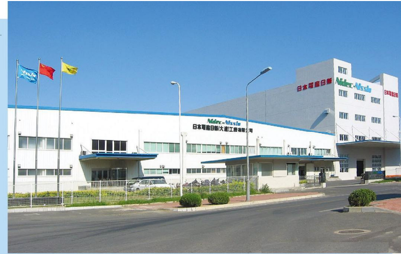
日本電産日新(大連)工機有限公司
